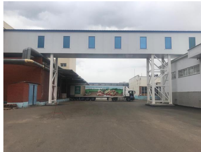
Галерея между 1 и 3 корпусом
